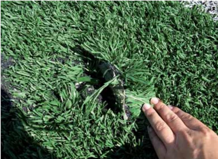
Figura 19. Rotura de una junta del césped artificial
